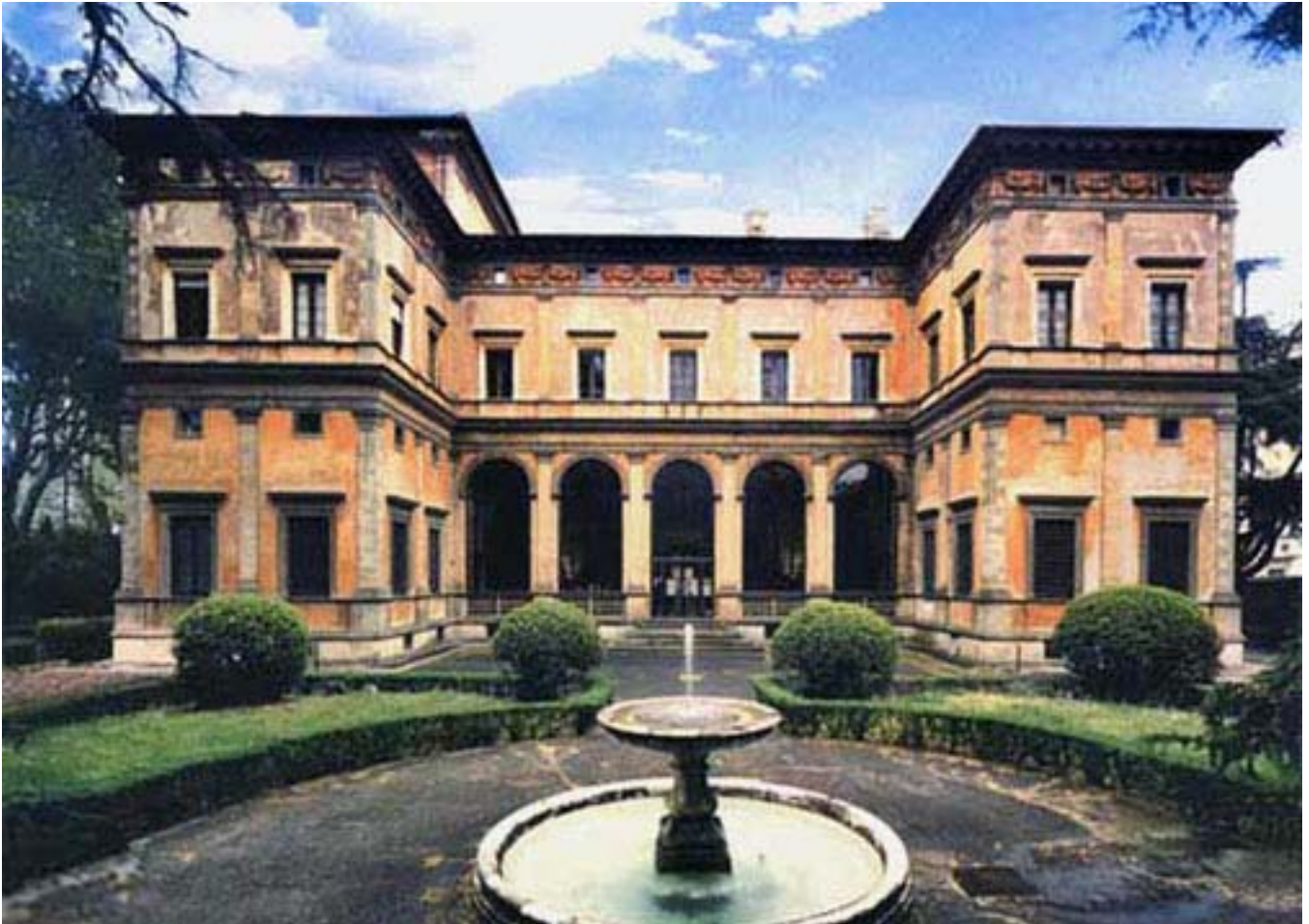
Fig. 7 Villa Farnesina, garden façade. Rome
